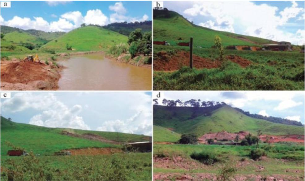
Figura 13: Remoção de sedimento da área de mata ciliar, transporte de material por caminhões e alocação do material em pilhas. Remoção do sedimento nas margens do rio (a), transporte de material para pilhas (b), construção das pilhas (c, d).
