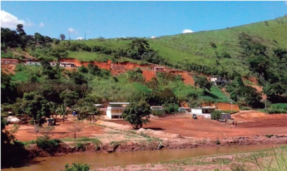
Figura 16: Preparo do solo e plantio em matas ciliares. Nota-se a diferença de coloração entre o solo impactado pelo rejeito e aquele que foi alocado para a mata ciliar, a utilização de técnicas de drenagem e a presença de maquinários utilizados no preparo do solo. Também é possível perceber a presença de uma área, cujo plantio não foi bem-sucedido.
