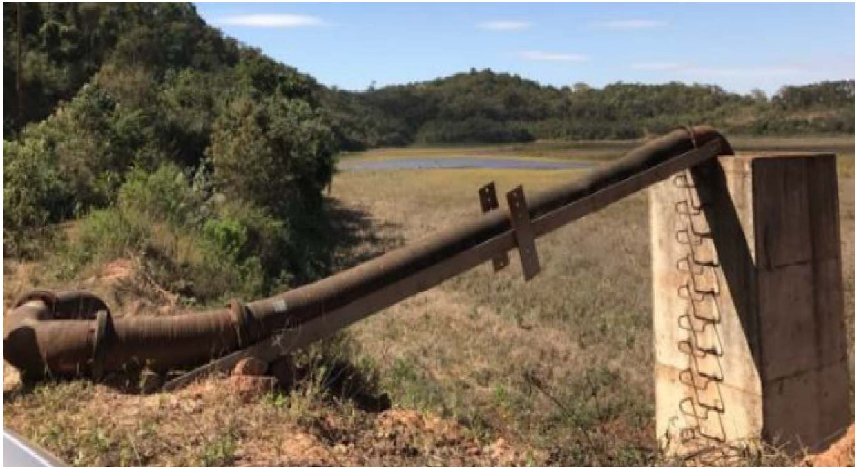
Figura 62: Tubulação de captação da água do lago (ao fundo) até a torre 3 do sistema extravasor
