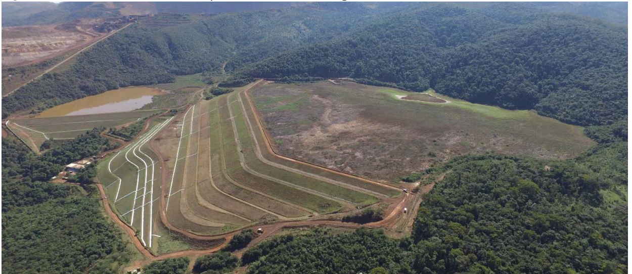
Figura 3: Vista aérea da B I, à esquerda vê-se a barragem B VI
