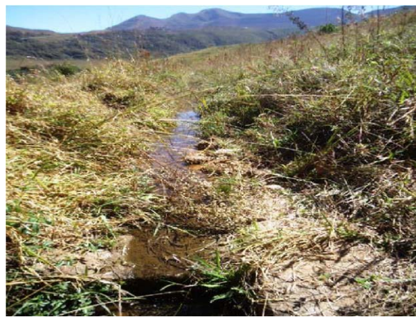
Figura 91: Vegetação alta obstruindo a canaleta de drenagem
