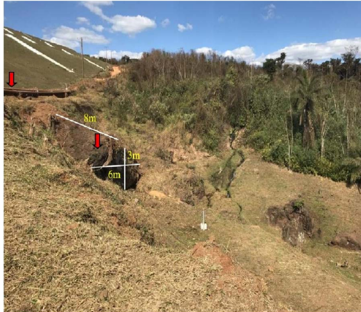
Figura 16: Vista do grande bloco de canga junto ao pé da B I
