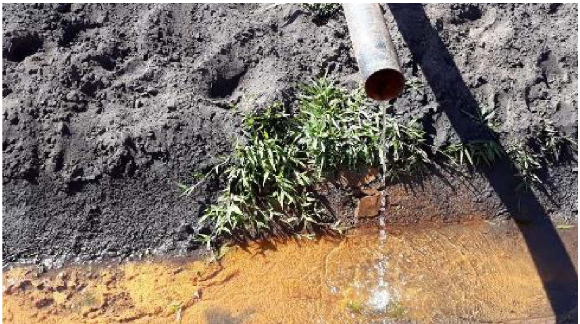
Figura 47: Saída de DHP com presença de colóide na B I
