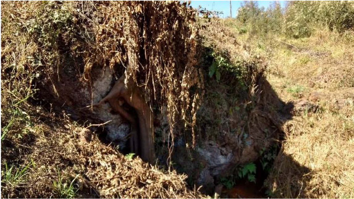
Figura 49: Vista da face exposta do grande bloco de canga existente à jusante do dique inicial da B I
