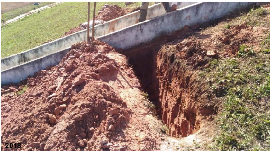
Figura 37: Vista de escavação realizada junto à canaleta onde ocorreu o fraturamento hidráulico em junho de 2018
