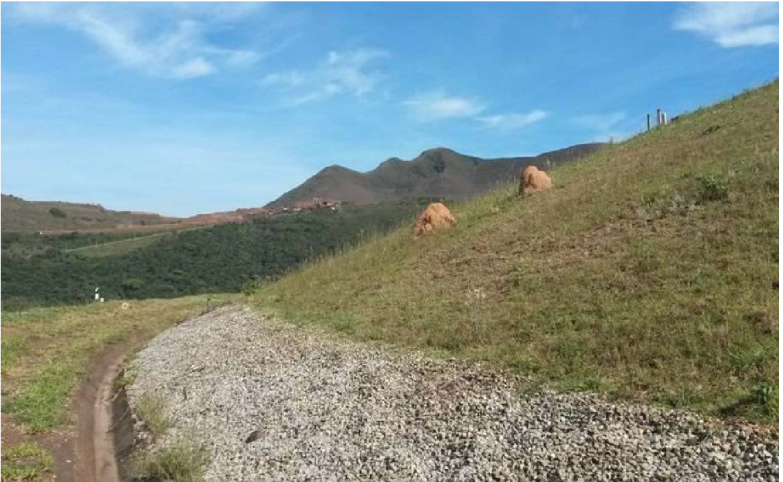
Figura 129: Formação de cupinzeiros no barramento
