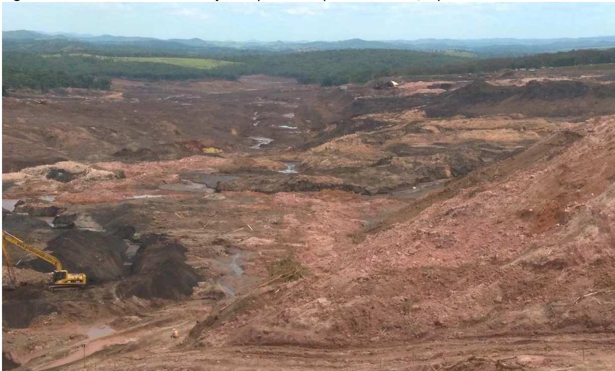
Figura 2: Visão do caminho do rejeito após o rompimento da B I, a partir da crista da B VI
