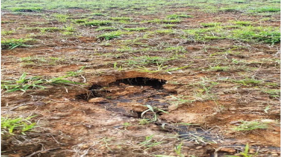
Figura 120: Erosão (ravina) no talude
