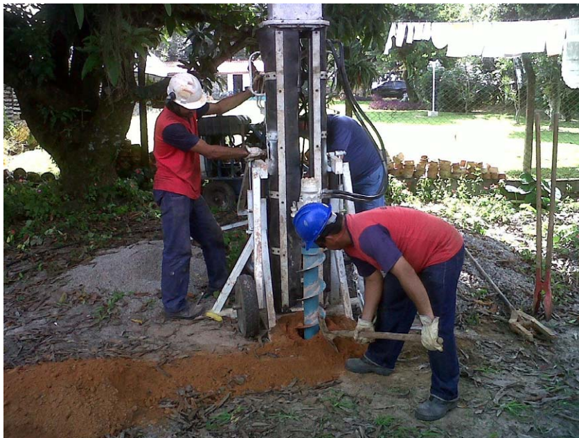
Figura 149: Execução de sondagem tipo hollow auger sem utilização de água
