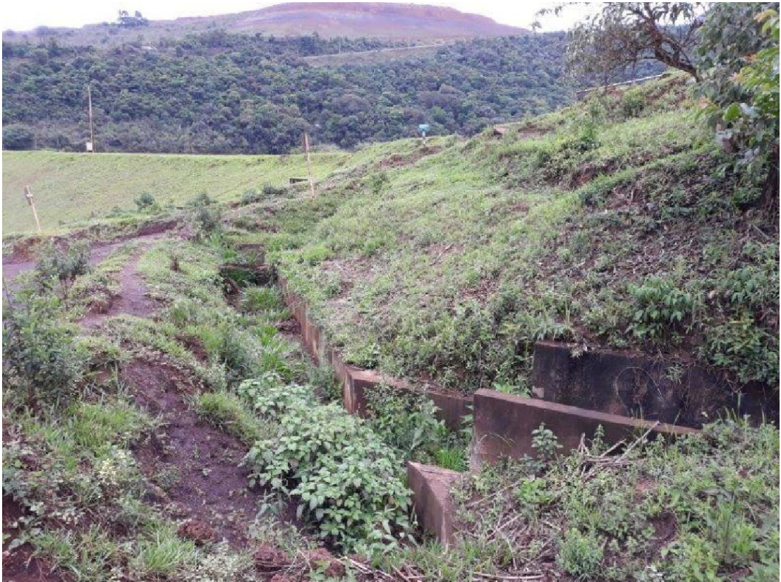
Figura 95: Vegetação arbustiva no talude do barramento e dentro das canaletas de drenagem
