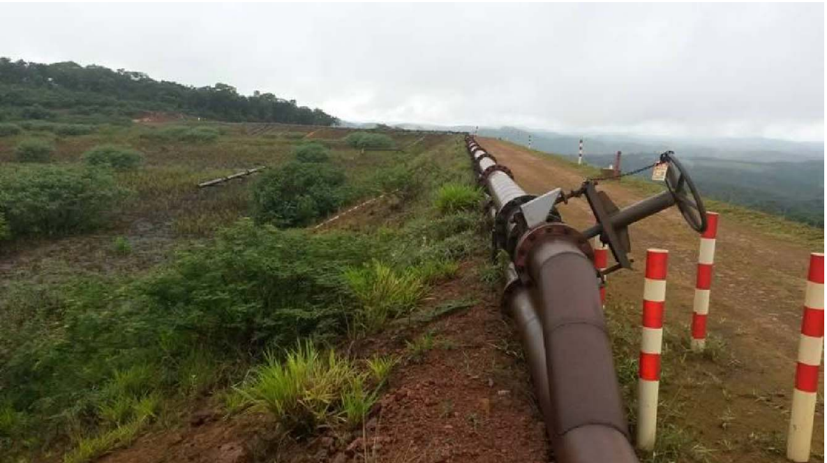
Figura 93: Vegetação arbustiva no talude de montante e dentro do reservatório
