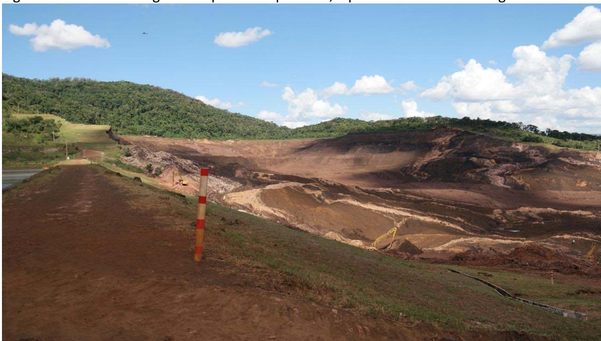
Figura 1: Visão da barragem B I após o rompimento, a partir da crista da barragem B VI
