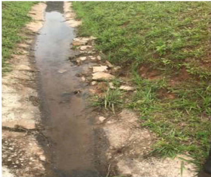
Figura 110: Canaleta de drenagem superficial parcialmente obstruída por lama
