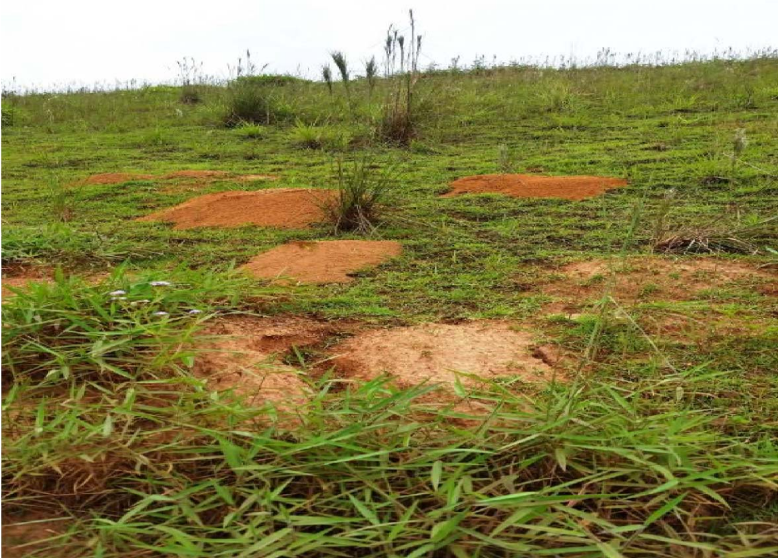
Figura 128: Formigueiros e cupinzeiros no barramento
