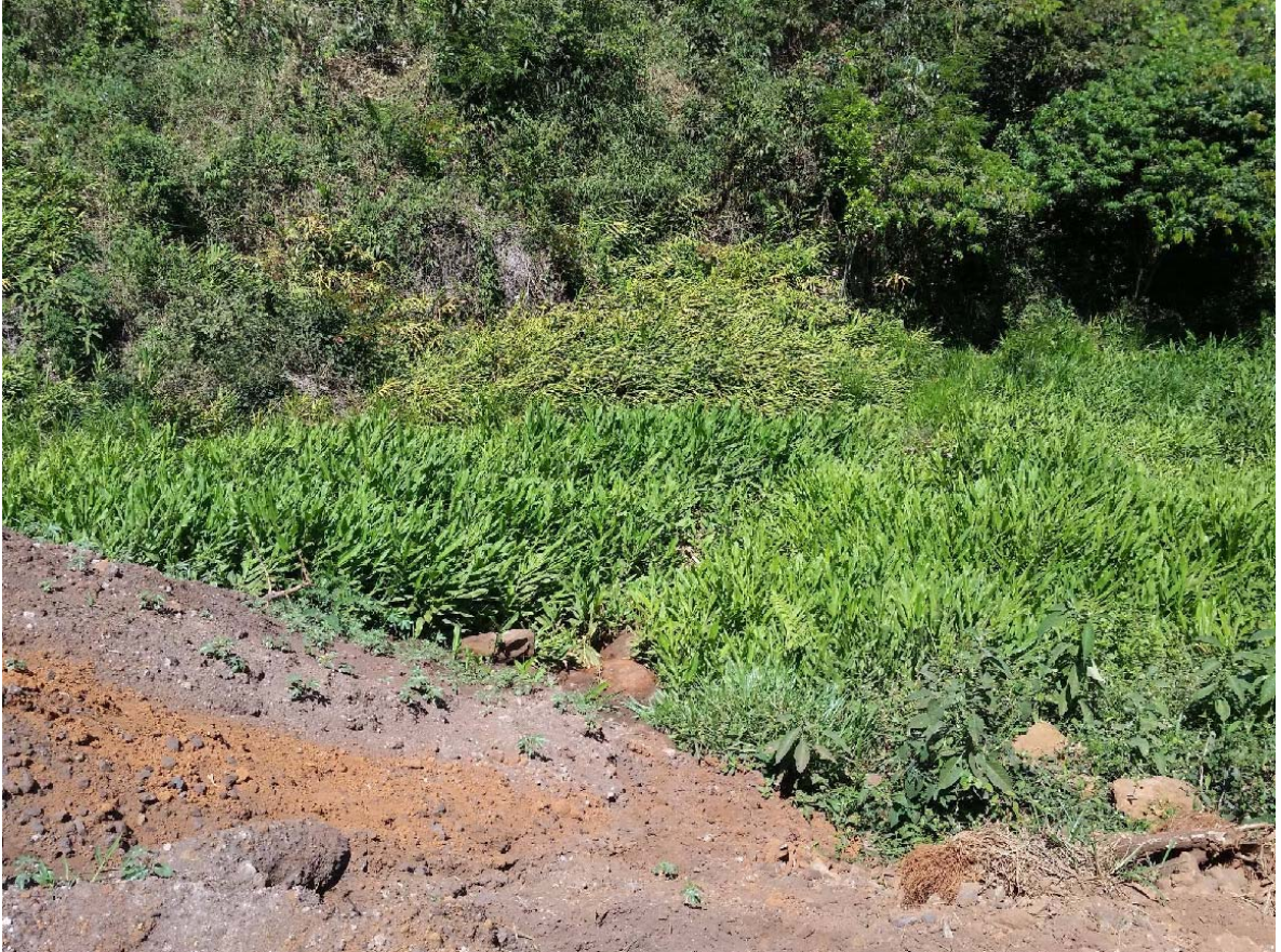
Figura 92: Vegetação alta no pé do talude
