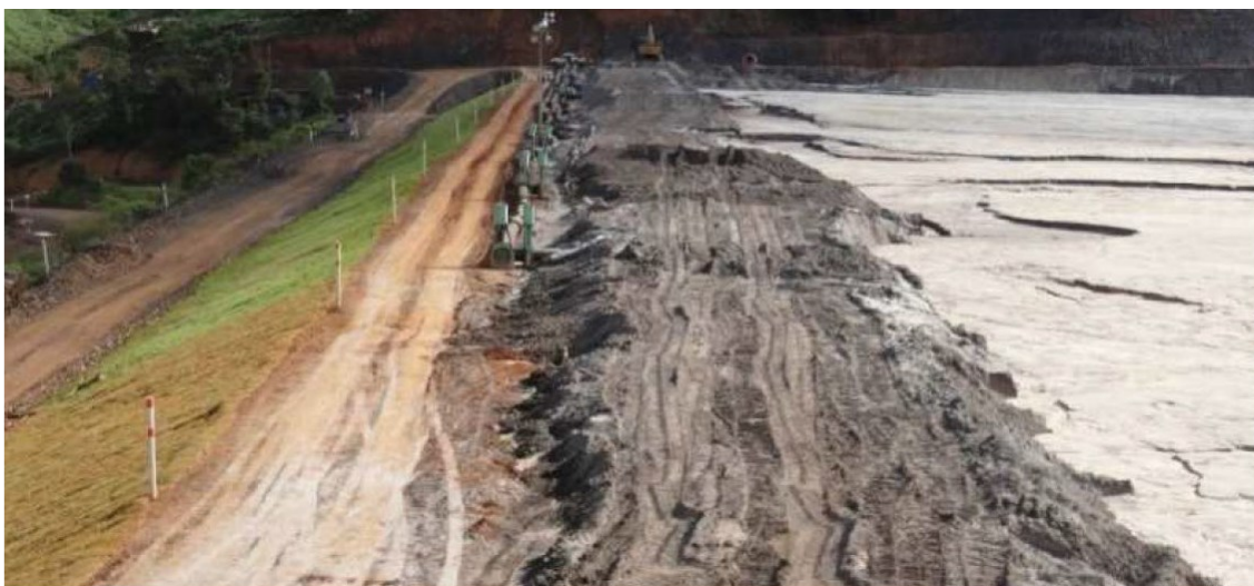
Figura 8 – Primeiro alteamento da barragem do Fundão 17 .
