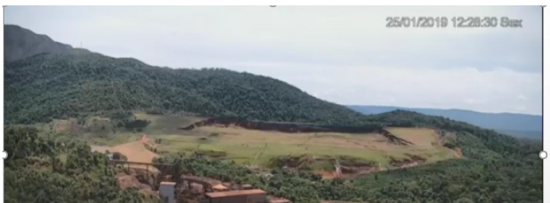
Figura 8 – Imagem capturada do momento de ruptura da Barragem I, mostrando o rompimento no terço inferior do maciço.
